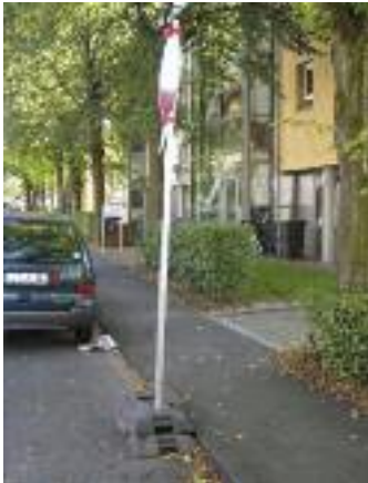
Bild 2: Aufstellung des Verkehrsschildes entgegen StVO und ohne ausreichende Standfestigkeit bei Wind (dieses Verkehrszeichen würde schon bei Windstärke 3 umfallen)
