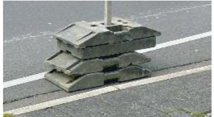
Bild 3: Schild fällt bei Wind nach rechts schneller um, als nach links (rechnerischer Hebel L nach Bild 1 kleiner)
