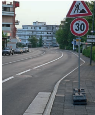
Bild 3: Die Baustelle wurde völlig geräumt, aber die Beschilderung nicht entfernt. Die Verkehrsteilnehmer müssen weiterhin die Verkehrsverbote beachten, auch wenn die Beschilderung jetzt ohne Genehmigung ist. Der Unternehmer kann für daraus entstehende Irritationen haftbar gemacht werden
