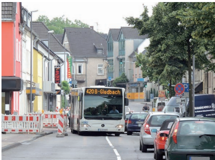
Bild 2: Verkehrsgefährdung im Bereich der Fahrbahn (fehlende Markierung)
