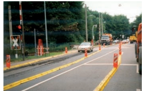
Bild 9: Längsmarkierung mit Leitschwellen innerorts
