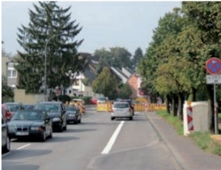
Bild 13: Fehlende Längsmarkierung zur Trennung vom Gegenverkehr (links) 1 bzw. fehlende Führung des Behelfsfahrestreifens (rechts) 2
