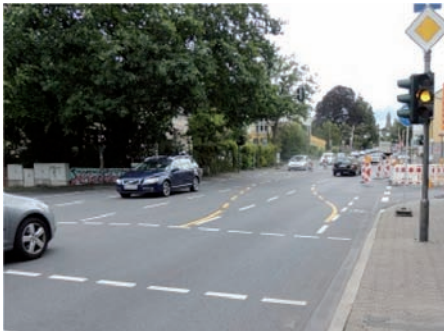
Bild 6: Vorübergehende Randmarkierung (Verlegung des Fahrbahnrandes ohne Leitbaken)
