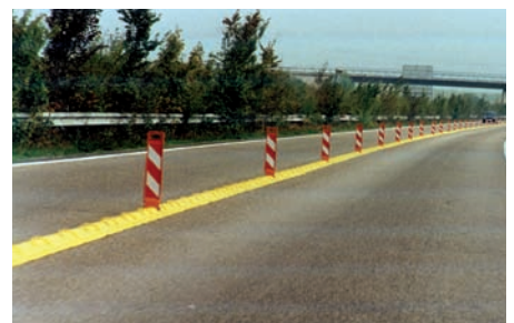
Bild 10: Längsmarkierung mit Leitschwellen außerorts
