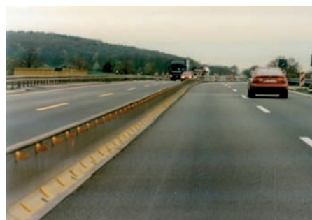
Bilder 12: Transportable Schutzeinrichtungen mit Markierung auf der Fußfläche (links) bzw. im Sockelbereich (rechts)
