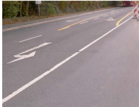
Bild 13: Fehlende Längsmarkierung zur Trennung vom Gegenverkehr (links) 1 bzw. fehlende Führung des Behelfsfahrestreifens (rechts) 2
