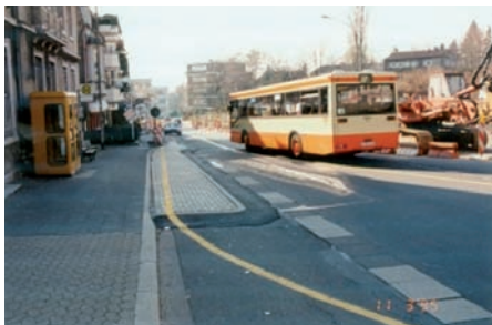
Bild 7: Randmarkierung führt über Gehweg (keine Leitbaken vorhanden)
