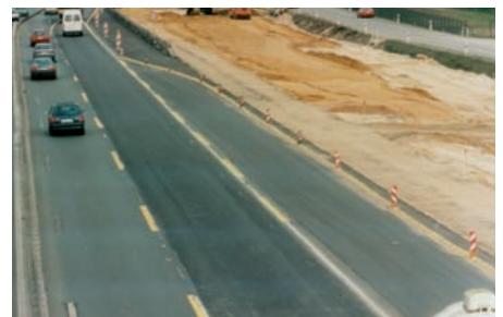
Bild 11: Leitschwellen zur Abgrenzung eines Beschleunigungstreifens nach RSA
