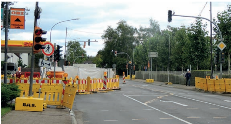
Bild 29: Sperrung mit Baustellenampel für Fußgänger
