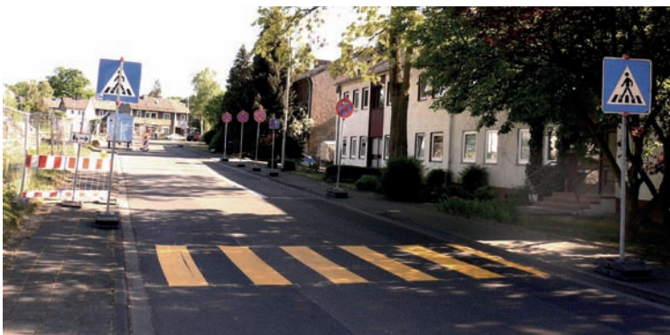
Bild 28: Vorübergehender Fußgängerüberweg gemäß StVO 2013 mit gelber Markierung
