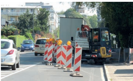
Bilder 31: Sperrungen von Gehwegen ohne Fußgängerführung
