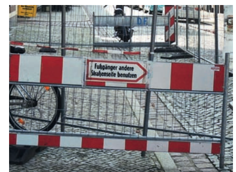
Bild 27a+b: Keine vorschriftsmäßige Sperrung und unzulässige Beschilderungen (fotografiert 2009 und 2014)
