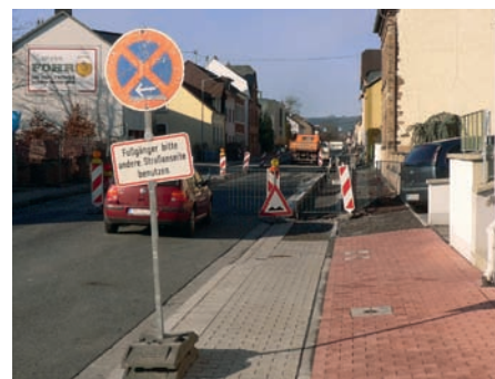
Bild 27a+b: Keine vorschriftsmäßige Sperrung und unzulässige Beschilderungen (fotografiert 2009 und 2014)
