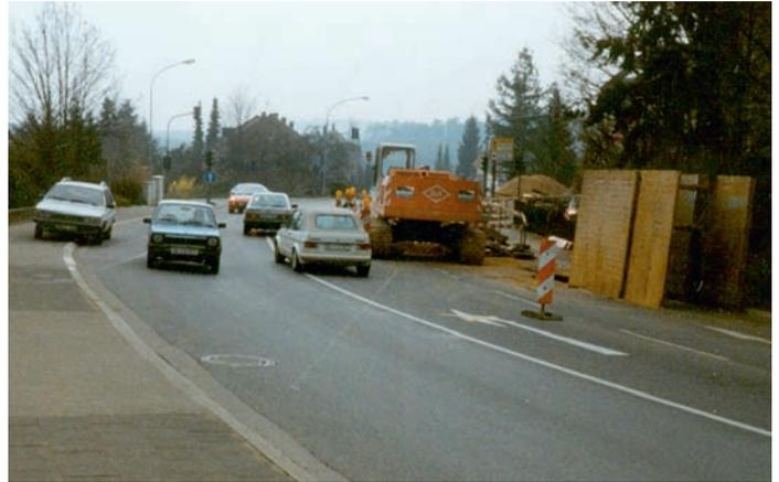
Bild 1: Nicht genehmigte Ausweitung der Baustelle mit Verkehrsgefährdung
