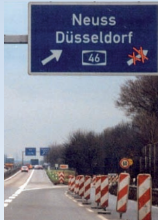
Bild 10: Hinweis auf gesperrten Fahrstreifen: korrekt (links), fehlend (rechts)
