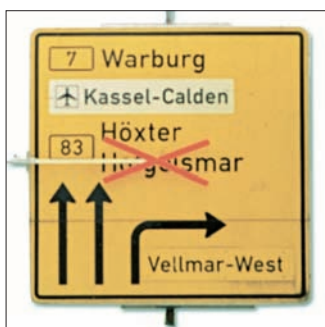
Bild 8: Vorübergehende Löschung einer Zielangabe mit gekreuzten Latten (links [Foto: Murken-Verkehrstechnik] bzw. Folienbändern (rechts))
