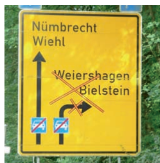
Bild 8: Vorübergehende Löschung einer Zielangabe mit gekreuzten Latten (links [Foto: Murken-Verkehrstechnik] bzw. Folienbändern (rechts))
