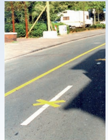
Bild 2: Überflüssiges Auskreuzen einer weißen Markierung
