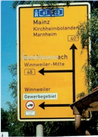
Bild 9: Unlesbar abgedeckte Zielangabe
