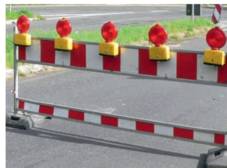
Bild 1: Anbringung von Warnleuchten an Absperrschranken: Korrekt (Bild oben), falsch (Bild unten)
