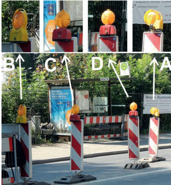
Bild 5: Eine innerörtliche Absperrung mit unterschiedlichen Leitbaken-Warnleuchten-Kombinationen
