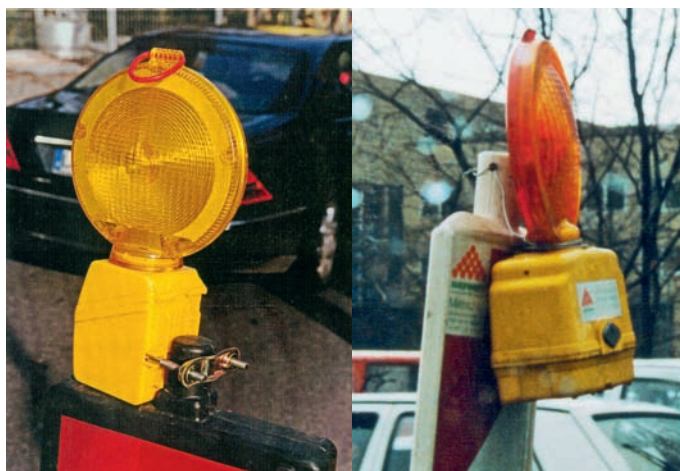
Bild 6: Klammer am oberen Ende des Bakenzapfens (rechts) bzw. Befestigungen mit Draht sind ungeeignet
