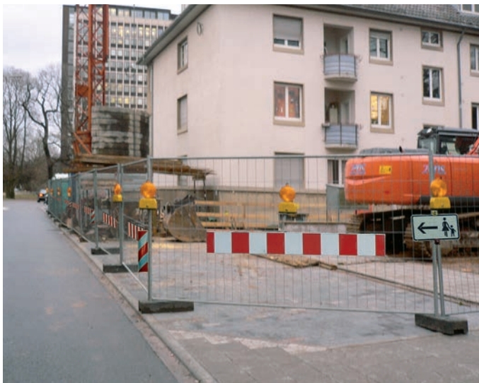
Bild 1: Ordnungsgemäß gekennzeichnete Bauzaun; Warnleuchten parallel zum Verkehr jedoch falsch (s. auch!)
