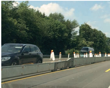
Bild 4: Transportable (temporäre) Schutzeinrichtungen aus Stahl und Beton
