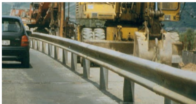
Bild 2: Im Baustellenbereich eingesetzte Standard-Stahlschutzplanken
