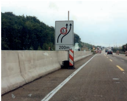
Bild 4: Transportable (temporäre) Schutzeinrichtungen aus Stahl und Beton
