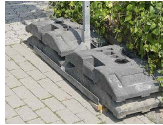
Bild 3: Pfosten in Fußplattenträger (Unebenheit vorne links durch Keil ausgeglichen)
