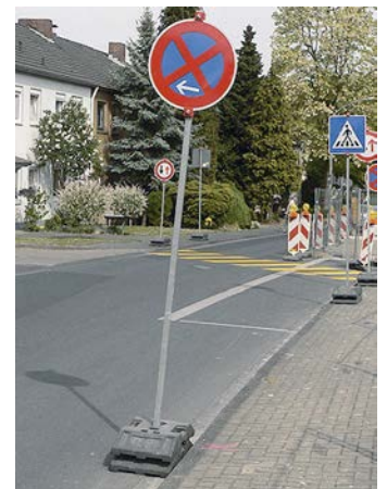
Bild 6: Nach RSA zulässige und korrekte Aufstellung
