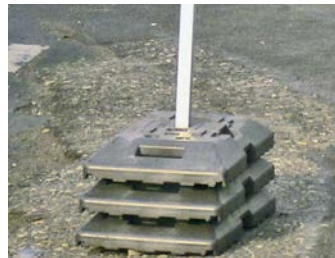
Bild 4: Aufstellung auf lockerem Kies
