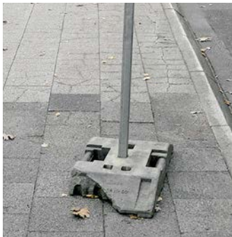
Bild 9: Defekte Fußplatte gewährt keine Standsicherheit
