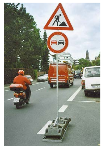
Bild 7: Hier fehlt die Sicherung zumindest durch eine Leitbake
