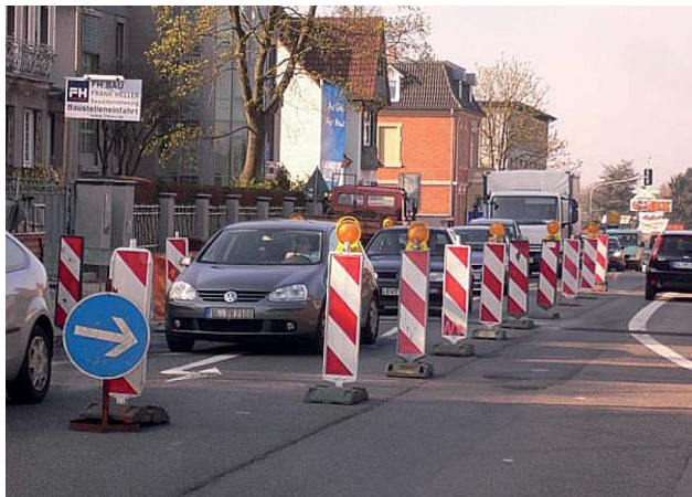
Bild 10: Falsche Anbringung von Zeichen 222
