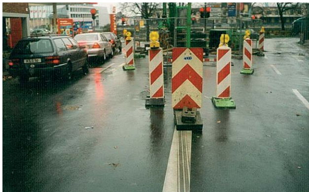
Bild 3: Gemäß VwV-StVO korrekte Kenzeichnung von Inselspitzen
