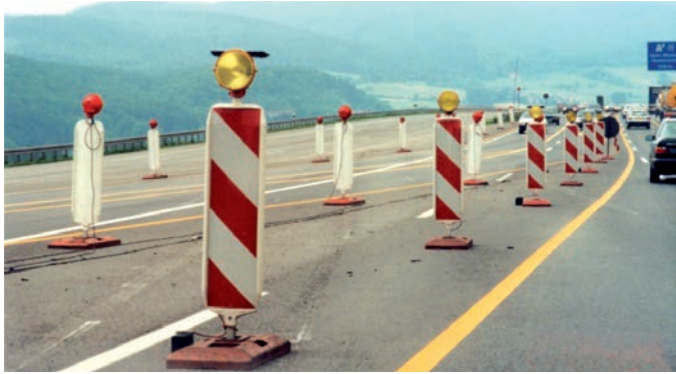
Bild 6: Korrekte Anwendung einseitiger Leitbaken
