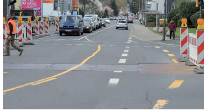
Bild 7: Unzulässiger Einsatz doppelseitiger Leitbaken links (zusätzlich teilweise falsche Schraffenrichtung)
